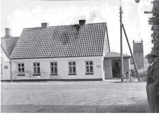
Centralbygningen i Nørskovlund
