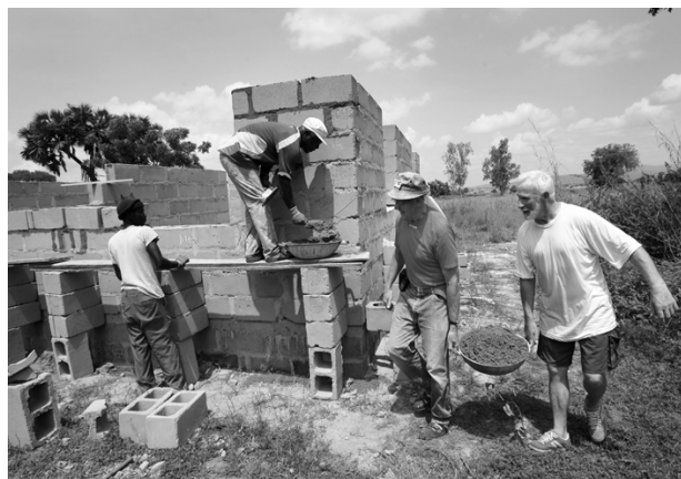
Henry og Ove bringer en cementblanding til deres nigerianske kollegaer.
